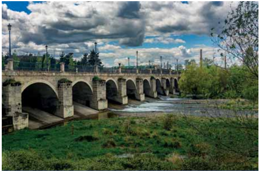
Figura 7. Vista del puente, desde la margen derecha
