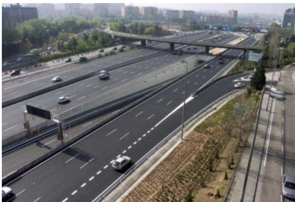
Vista aérea de la entrada del túnel en la M-30.
