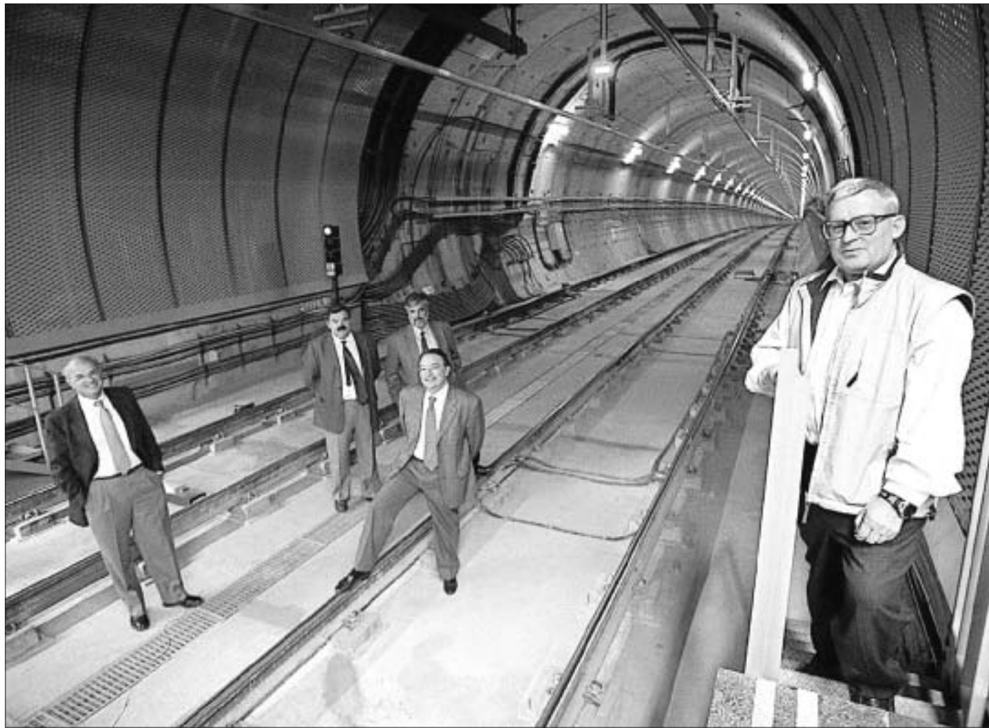
El presidente de Metro, Manuel Melis, a la derecha, junto a otros responsables del metrosur, en los túneles de la estación Alcorcón Central. / ULY MARTÍN
