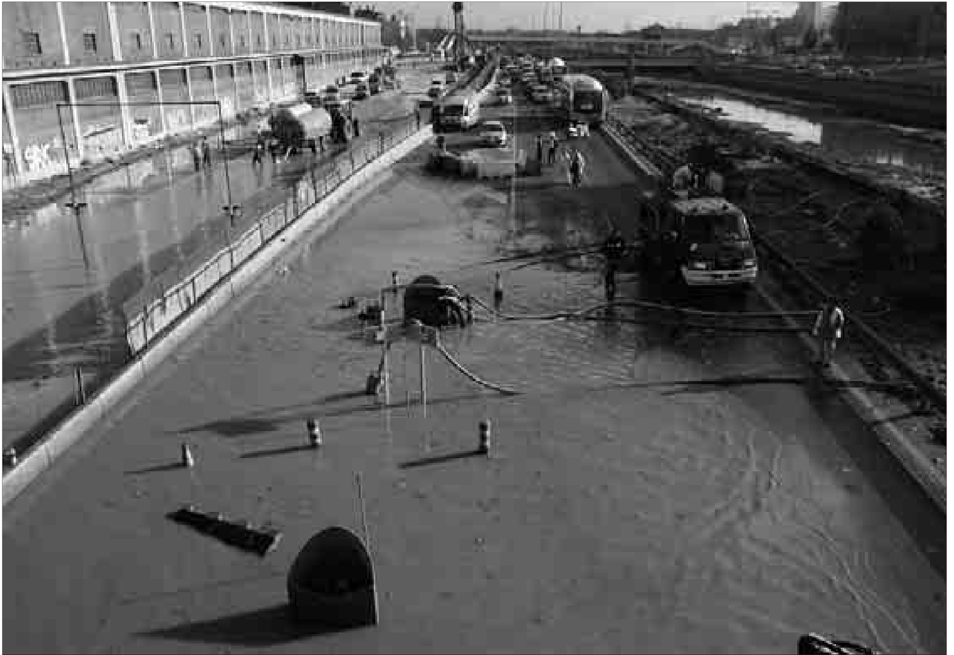
Los bomberos achican el agua acumulada sobre la M-30, ayer por la tarde, poco después de que una excavadora que trabaja en las obras de la autovía rompiera una tubería del Canal. / KIKE PARA
