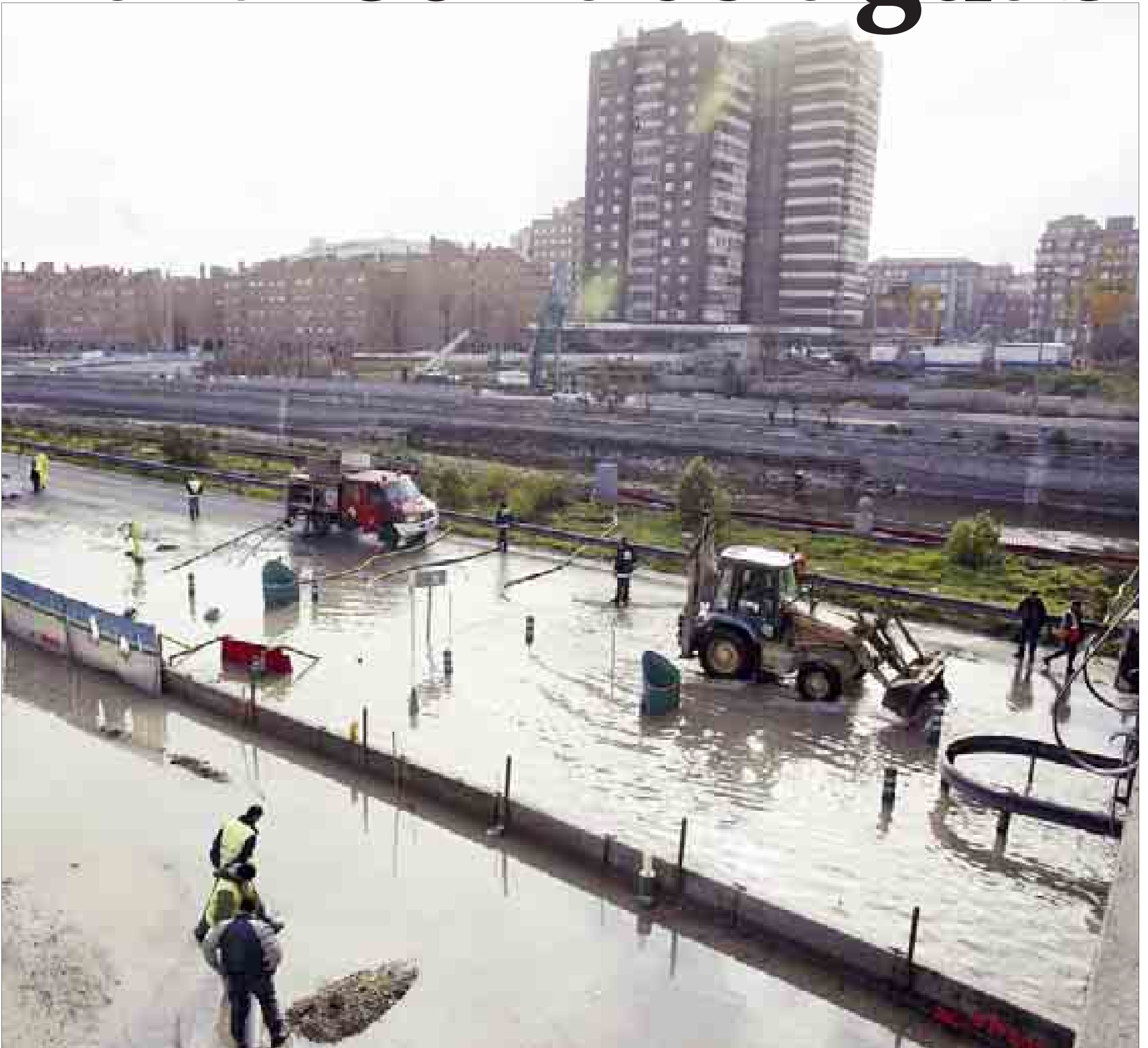
Varios operarios trabajan en los carriles de la M-30 inundados a última hora de la mañana de ayer. / KIKE PARA
