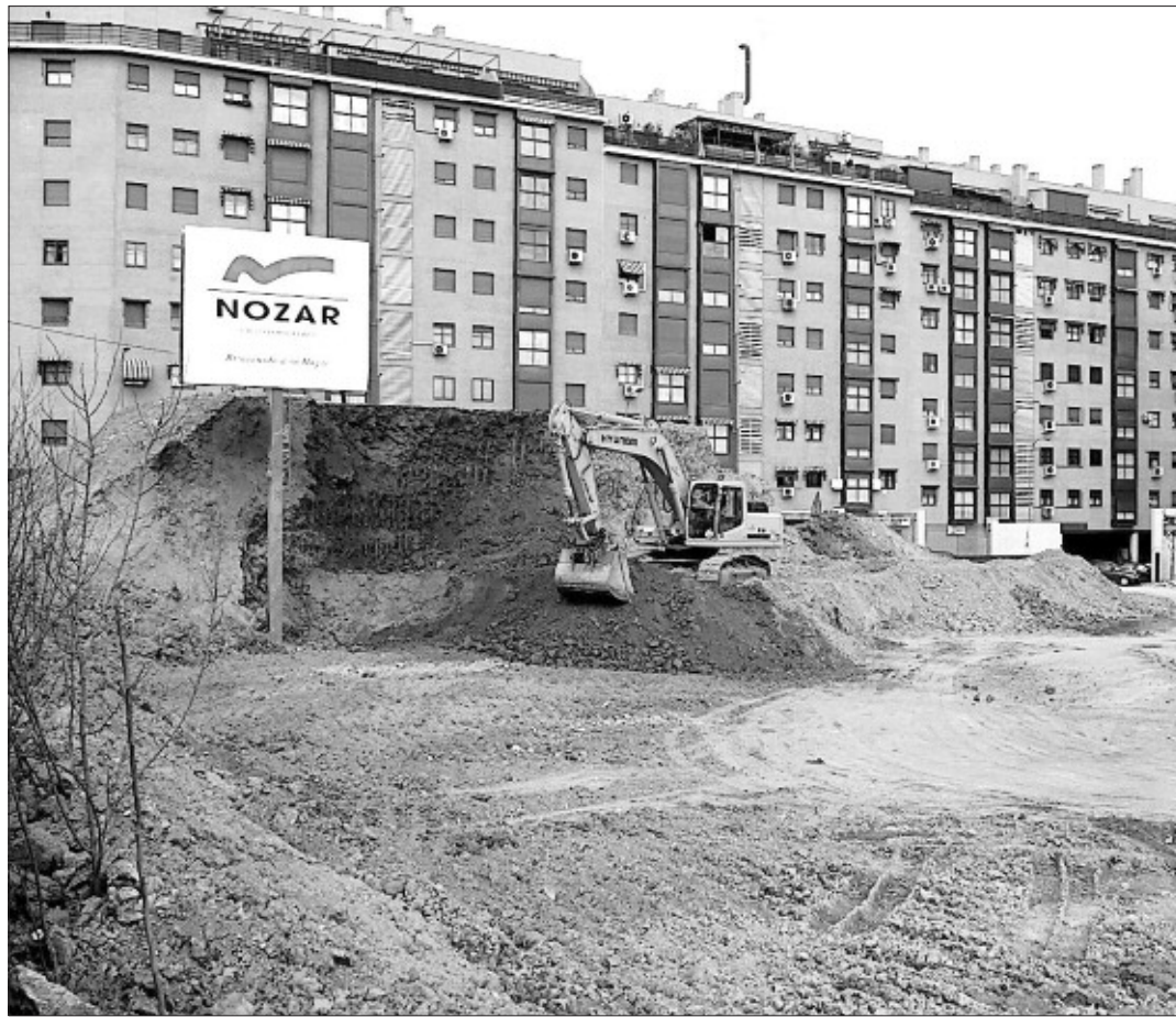
Tierra procedente de las obras de la M-30 en un solar de la calle de Antonio López. / J. S. G.
