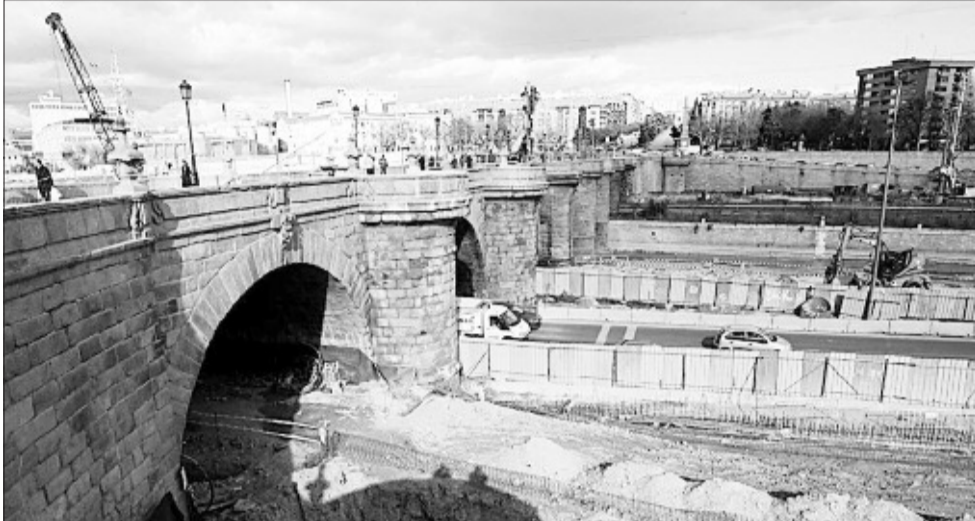
Obras de la M-30 bajo el puente de Toledo. / CRISTÓBAL MANUEL
