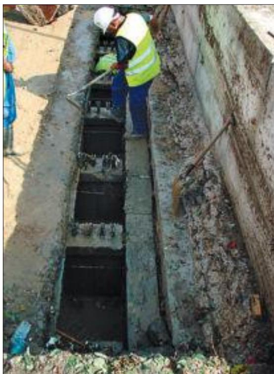
Obras de la pasarela por donde entró el agua. Filtraciones que se produjeron en el techo del túnel de la M-30.
