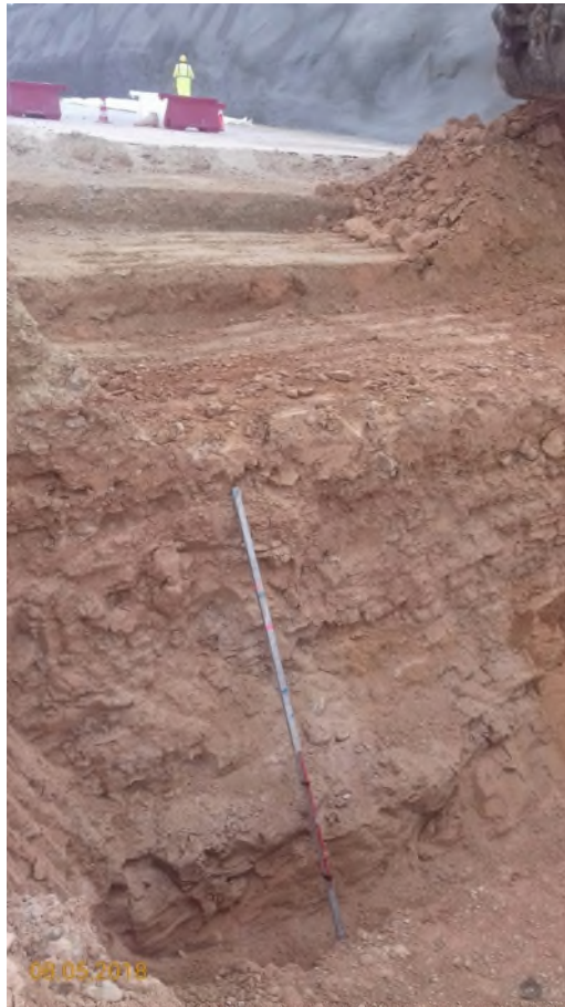
Foto 18.- Profundidad de excavación de la zanja en la obra de la Foto 15
