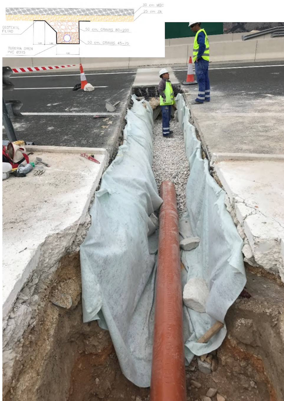
Foto 24.- Ejemplo de ejecución a posteriori, con la carretera en servicio
