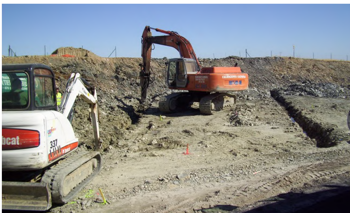
Foto 30.- Ejecución de zanjas para captación de afloramientos según alineaciones
