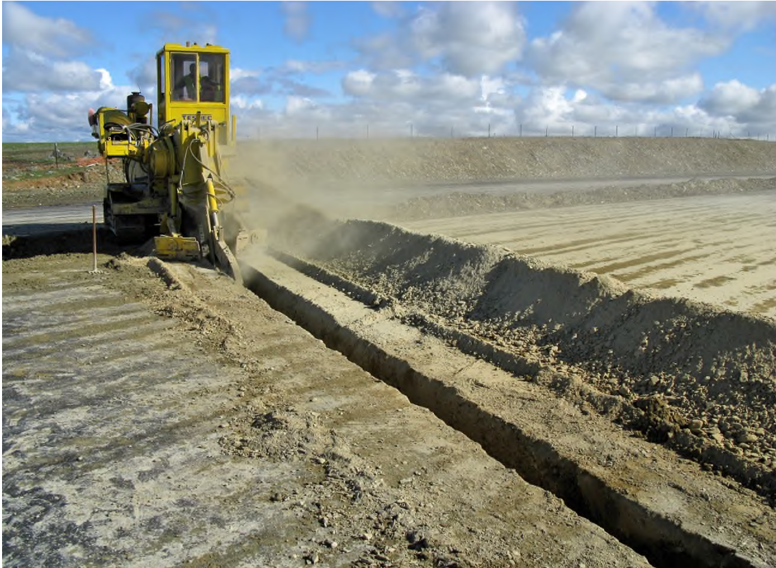
Foto 22.- Ejecución mediante zanjadora, de zanja drenante intermedia en desmonte de gran longitud
