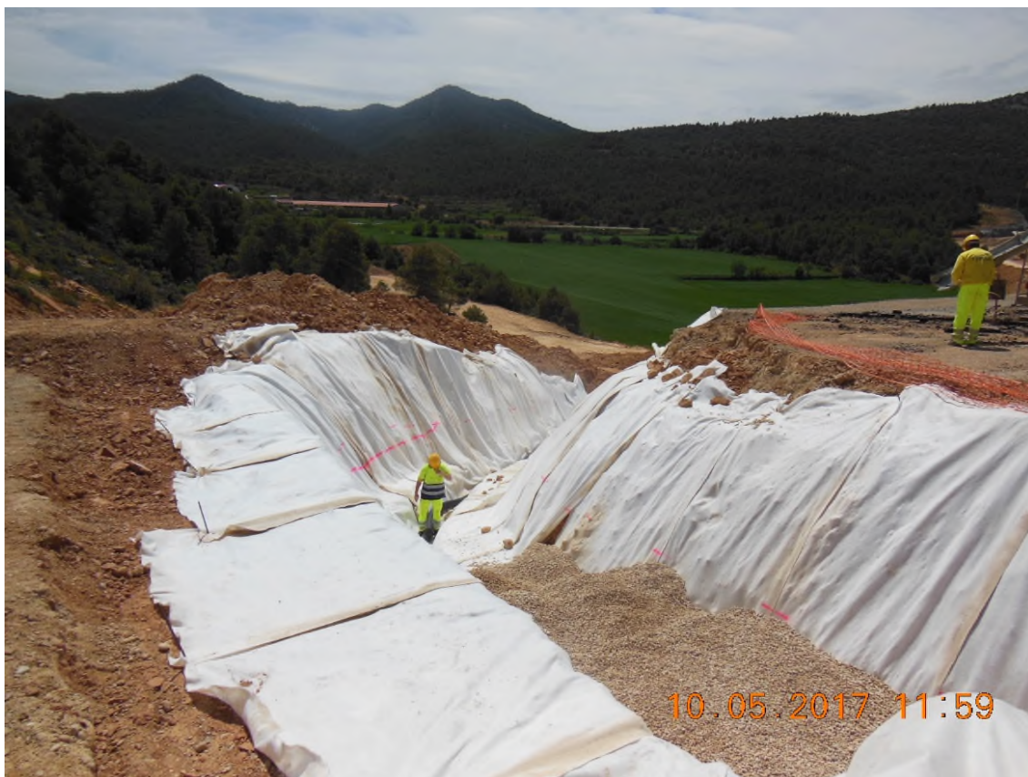
Foto 21.- Detalles de ejecución de la zanja de la Foto 15. Geotextil de separación y filtro, tubería drenante, relleno de grava y excavación hacia punto de vertido
