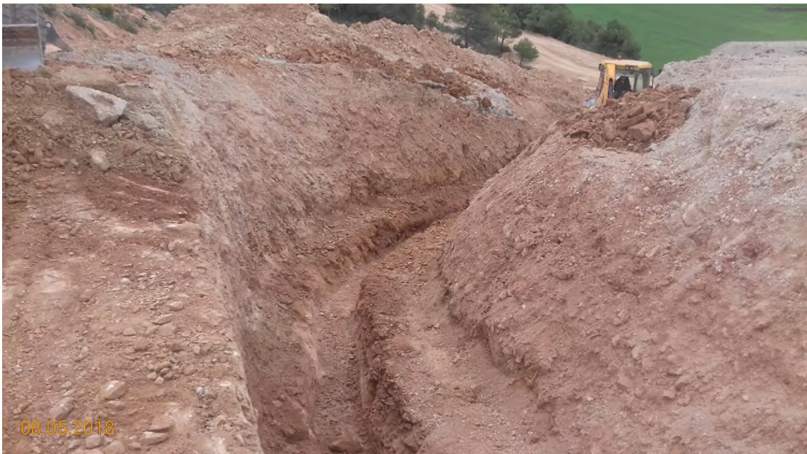
Foto 19.- Ejecución de la zanja de la obra de la Foto 15
