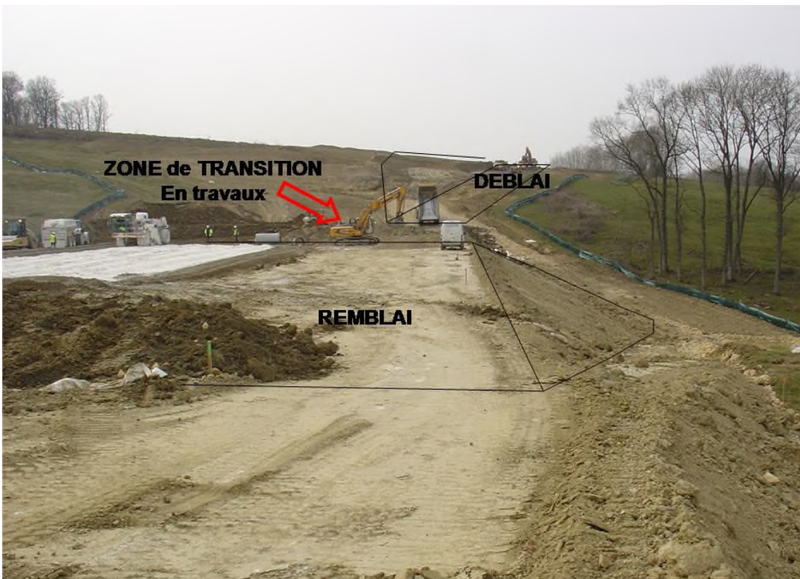
Foto 23.- Imagen de la Administración Francesa relativa a la ejecución de una zanja drenante en la transición de un desmonte (déblai), hacia un terraplén (remblai) en sentido descendente de la rasante http://wikiklimat.developpement-durable.gouv.fr/index.php/Wikigeotech:Zone_de_transition
