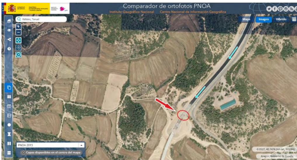
Ortofoto 16.- Emplazamiento de la Foto 15. Nótese la gran longitud y fuerte pendiente (Plano 25) del desmote que antecede al terraplén de acceso al viaducto
