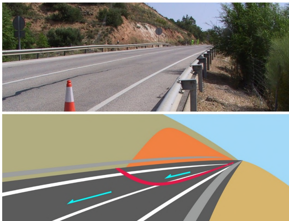
Foto 12.- Transición desde sección transversal a media ladera, a sección transversal en terraplén, en sentido descendente de la rasante. En esta situación el contacto entre desmonte y terraplén tiene la forma indicada en la figura. Obsérvese el asiento gracias en la barrera metálica junto al desmonte
