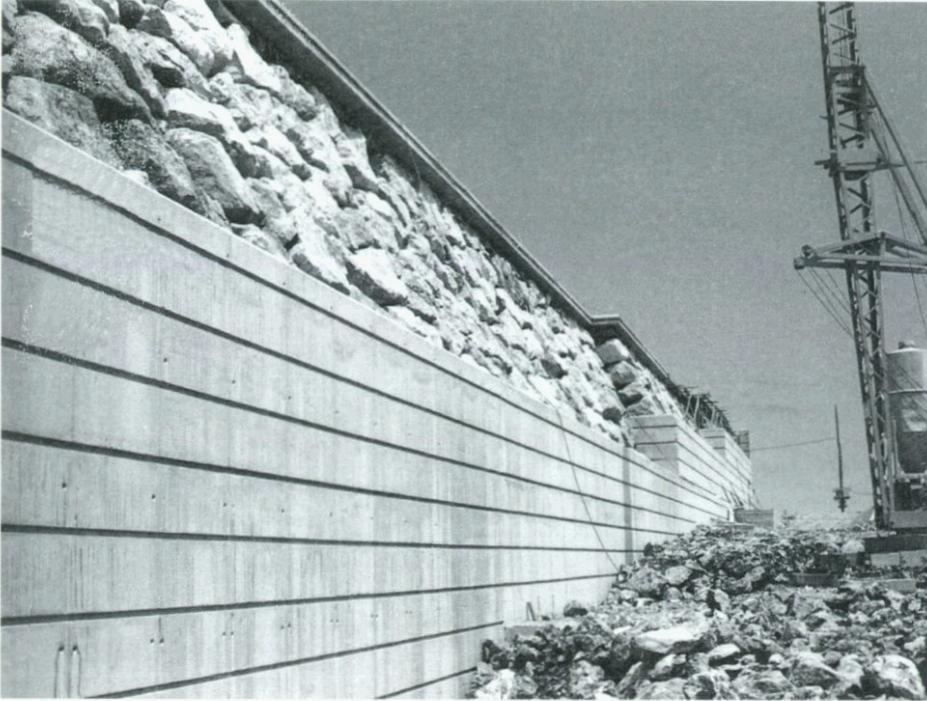
Muro mixto de Hormigón armado y Escollera.
