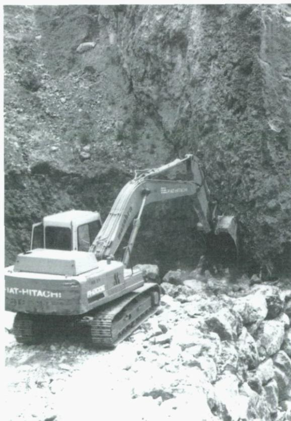
Colocación del material de trasdós del muro
