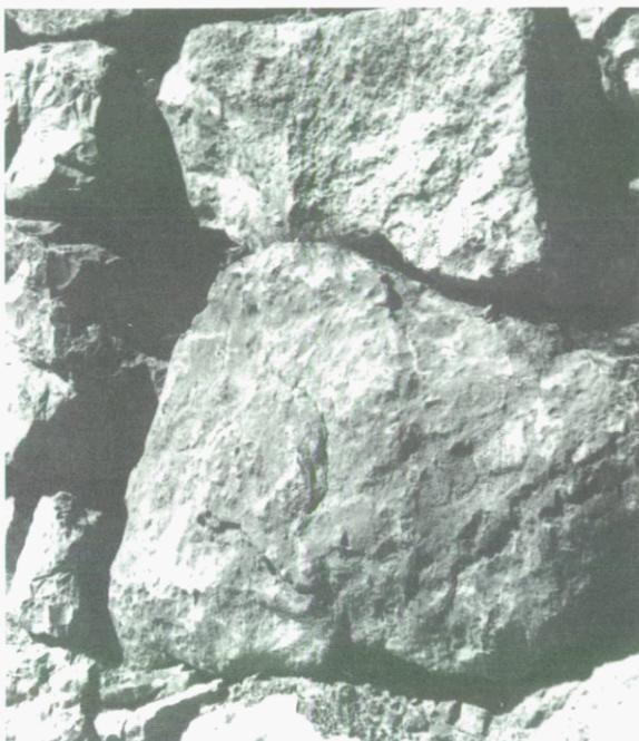
Bloques de roca caliza de peso superior a 30 kN (3000 kg). utilizados en la construcción de un muro de escollera. Carretera de Bárcena Mayor (Cantabria)
