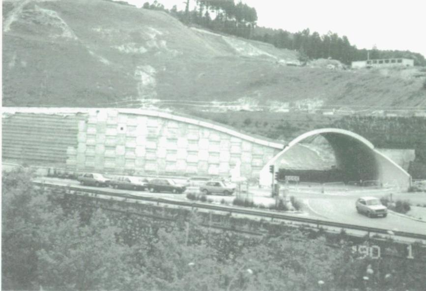
Muro de Tierra Armada utilizando Escamas de Hormigón y Geotextil.
