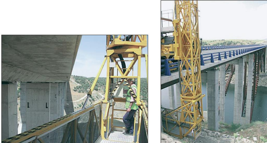
FIGURA 2. MEDIOS DE ACCESO EN UNA INSPECCIÓN ESPECIAL O DETALLADA
