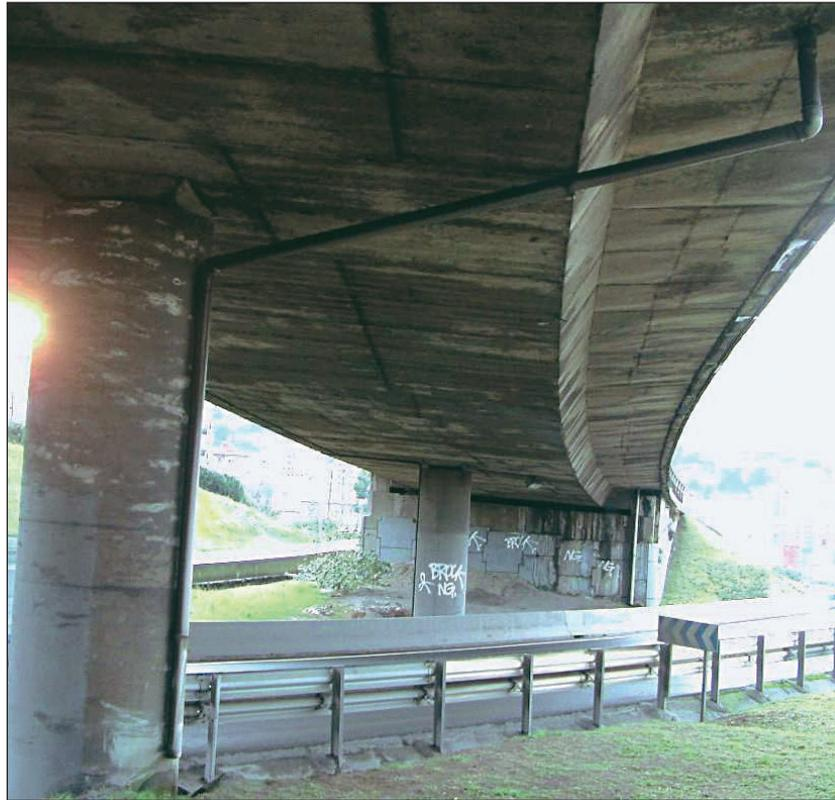
FIGURA 55. TUBO DE DESAGÜE
