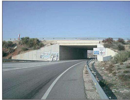
FIGURAS 3 Y 4. TABLERO SOBRE PILAS/ESTRIBOS
