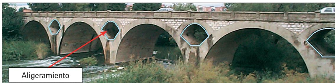
FIGURA 11. ELEMENTOS DE UNA BÓVEDA
