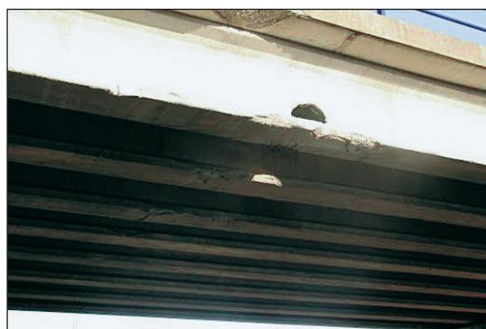
FIGURA 30. ROTURA DE VIGA POR IMPACTO
