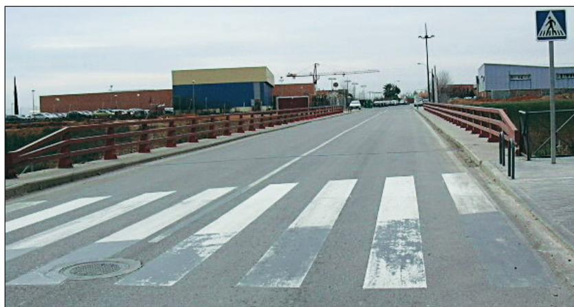
FIGURA 62. SEÑALIZACIÓN HORIZONTAL Y VERTICAL
