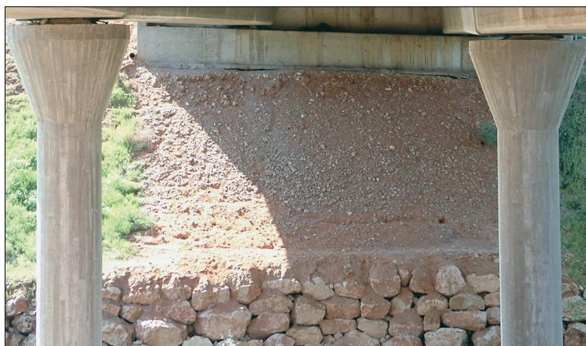
FIGURA 67. VIGA DURMIENTE SOBRE TERRAPLÉN.
