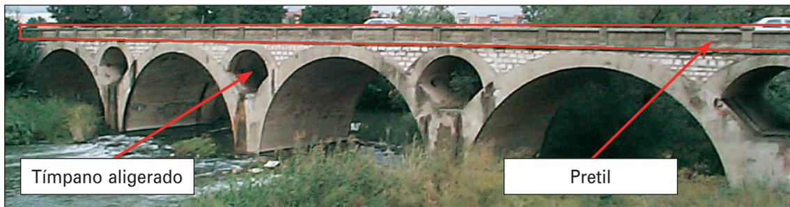
FIGURA 10. ELEMENTOS DE UNA BÓVEDA
