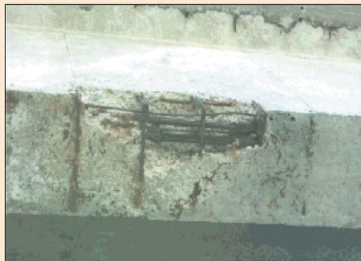
Las armaduras que quedan vistas pueden presentar otros daños que agravan el grado de deterioro de la obra de paso, como es la rotura o la deformación excesiva de las barras de armado.
