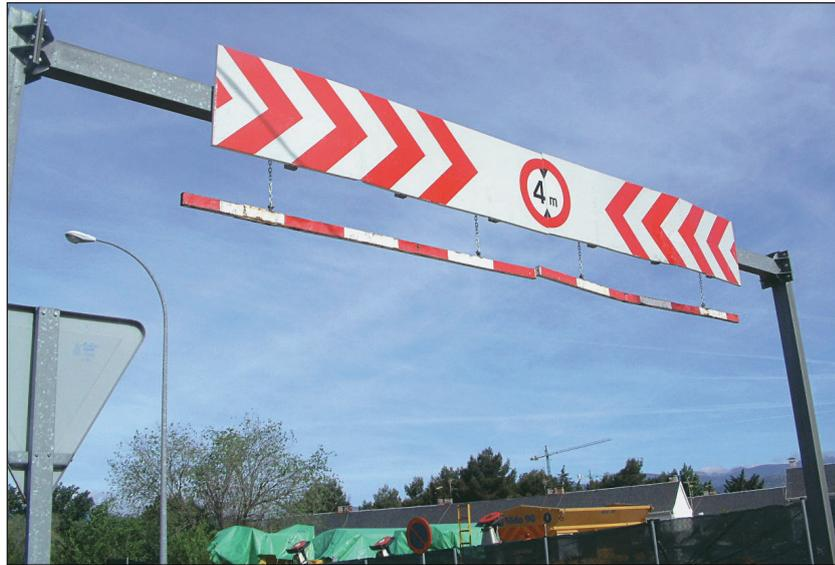
FIGURA 60. SEÑALIZACIÓN PREGÁLIBO
