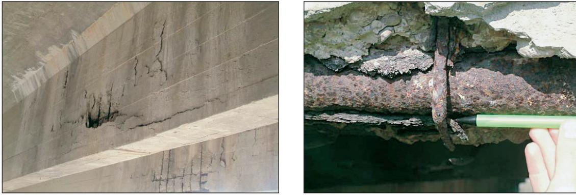
**FIGURAS 31 Y 32. CORROSIÓN DE ARMADURAS EN VIGAS (FOTOGRAFÍA IZQUIERDA)
