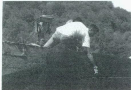
6. Colocación y compactación de la tierra vegetal. En determinadas ocasiones se puede primero compactar la tierra vegetal y posteriormente el material de relleno.
