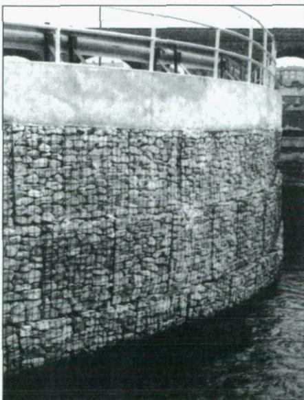
Fig. 7-1. Muro de gaviones
