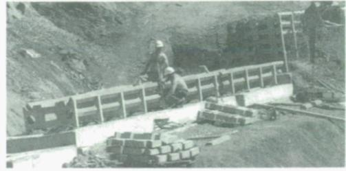
4. Montaje de las sucesivas hiladas del muro. Las piezas pueden ser descargadas, mediante una grúa o manualmente (dependiendo del tamaño de las piezas).
