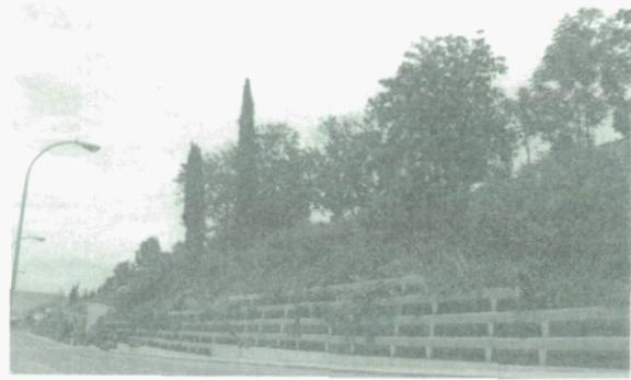
Fig. 9-12. Muro de módulos prefabricados verdes (EVERGREEN)
