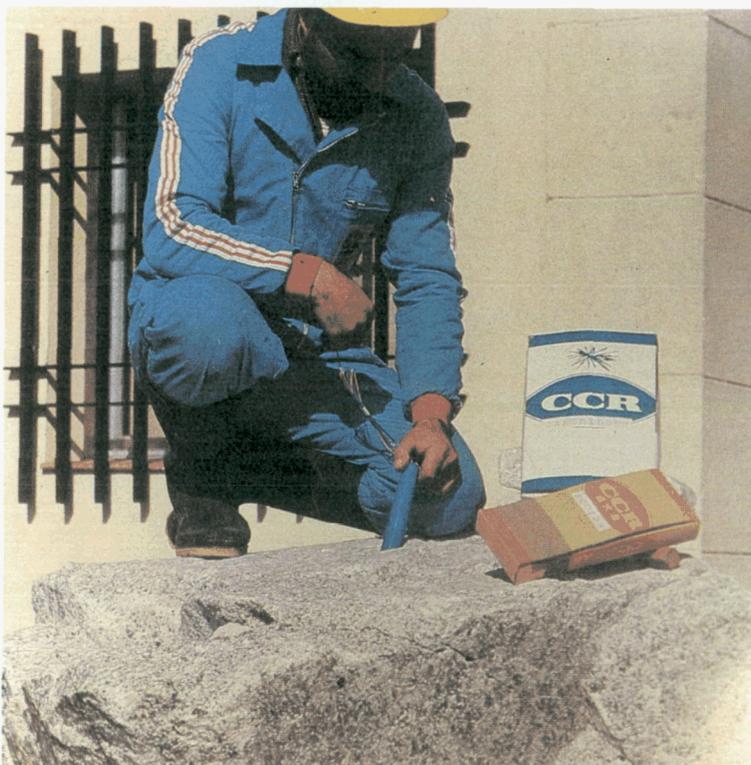
Foto 6.14.- Explosivo C.C.R. de bajo nivel de vibración para trabajos especiales de demolición y taqueo. (Cortesía de U.E.E.).
