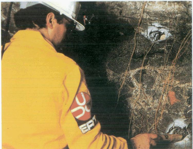
Foto 6.30.- Introducción de un cartucho cebo en un barreno correspondiente a una voladura en túnel (Cortesía de U.E.E.)
