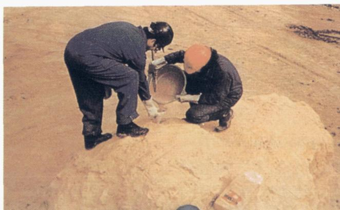
Foto 6.15.- Preparación de la mezcla y llenado del barreno con cemento expansivo tipo Bristar 6000 (Cortesía de U.E.E.)
