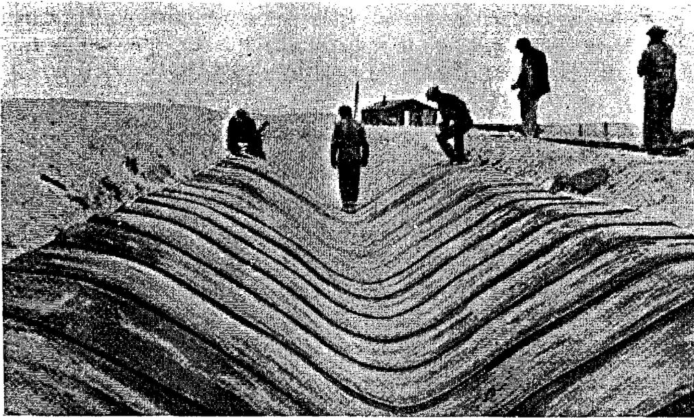
Figura XIII-4—Depósito industrial revestido con paneles asfálticos prefabricados
