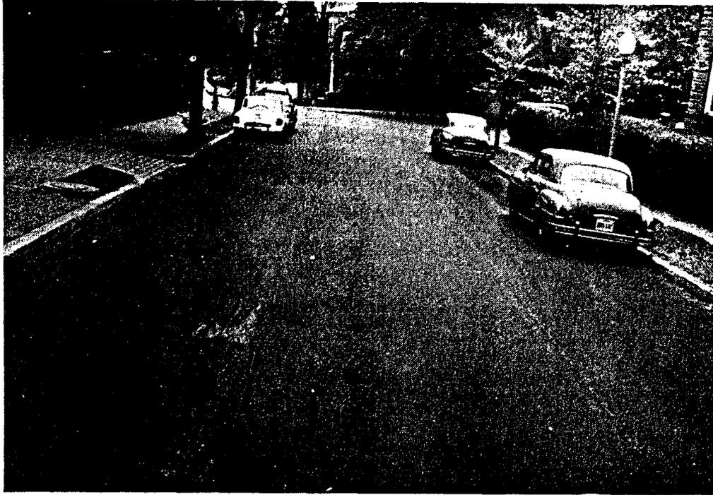
Figura VII-17—Una calle de Washington DC dos semanas después de la aplicación de un sellado con lechada asfáltica
