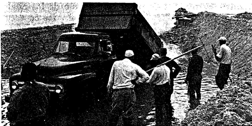
Aplicación de la mezcla en caliente en el extremo del mar. Durante la construcción había aproximadamente 1 m de agua
