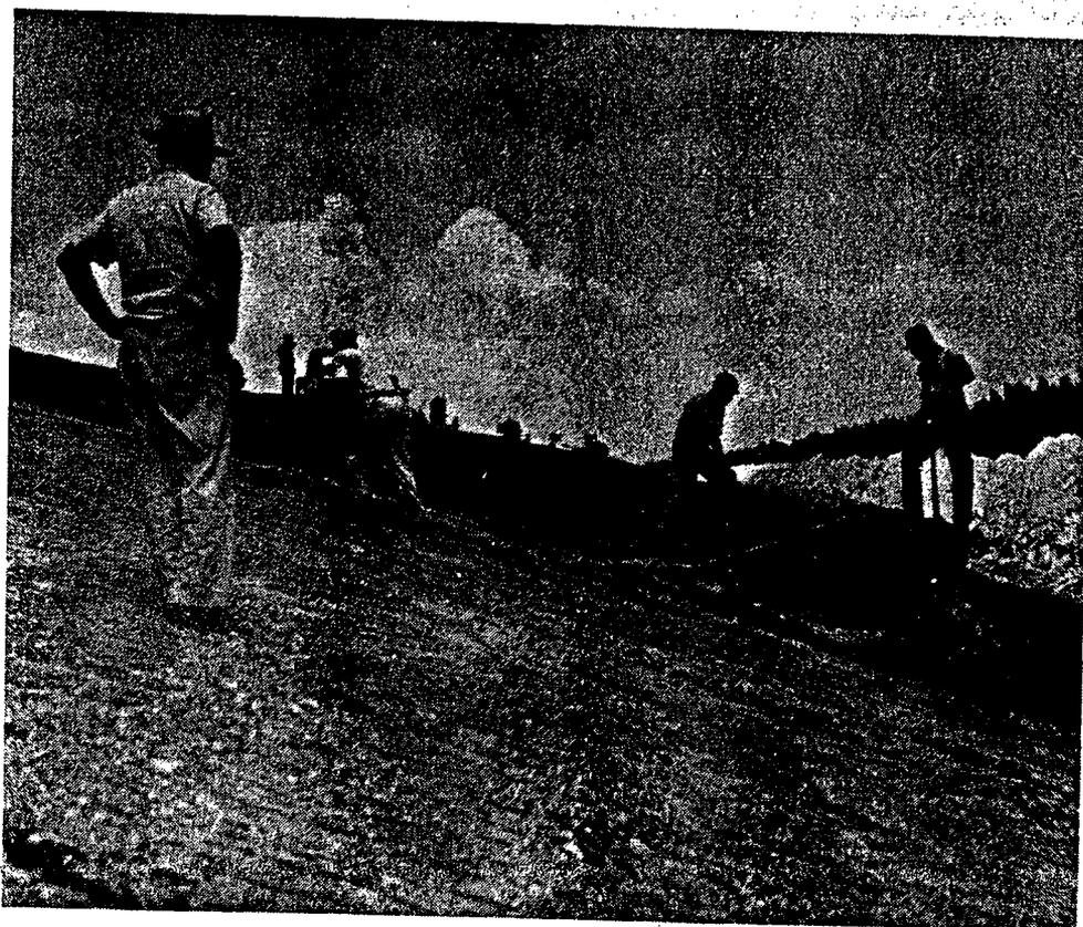
Figura XIII-7—Pavimentación del paramento de un dique
