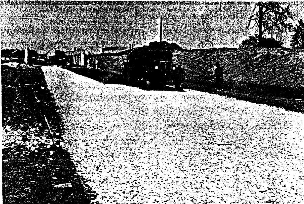
Figura VII-16—Construcción de una base de macadam asfáltico en la New Jersey Turnpike
