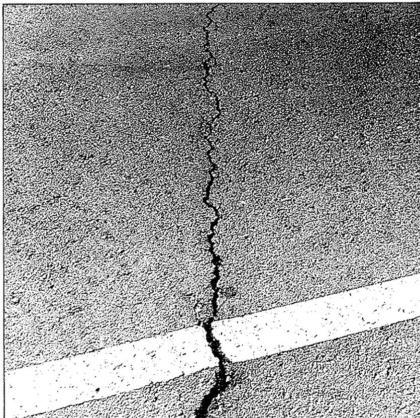
*Es una línea de rotura transversal o sensiblemente perpendicular al eje de la carretera.*
