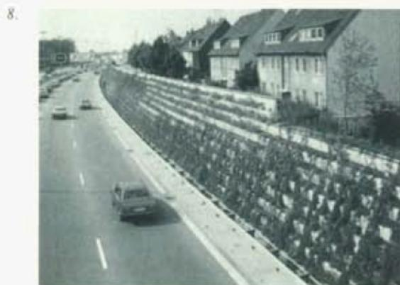
tituída por paneles prefabricados de 2 a 4 m<sup>2</sup>.
