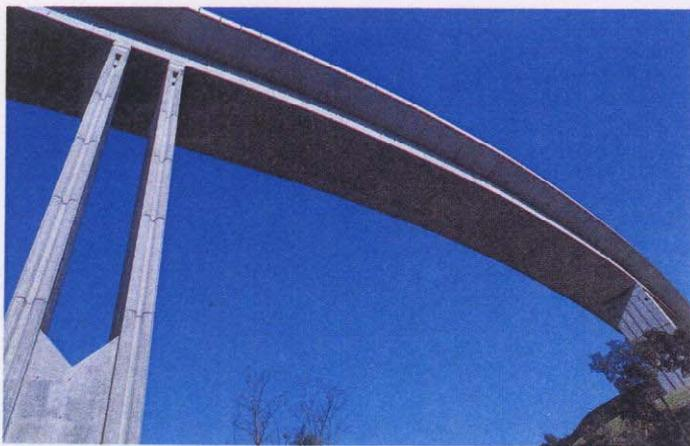
Esta técnica no es nueva, aunque si lo es la razón para su aplicación. Al emplearse dovelas prefabricadas, se centraliza la producción de hormigón en el parque de prefabricados, con la consiguiente menor ocupación del suelo durante la ejecución en obra. Dado el reducido tamaño de las dovelas no son precisos equipos de transporte especiales, ni tampoco caminos
