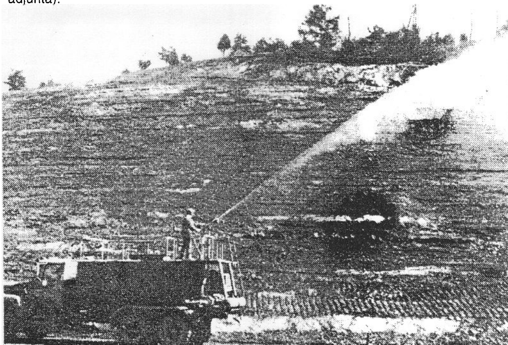
Máquina hidrosembradora trabajando
