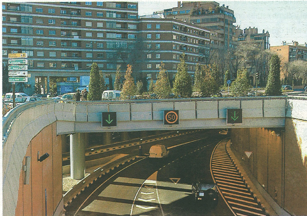
Túnel de Costa Rica. Ha mejorado el tráfico en la plaza de José María Soler.
