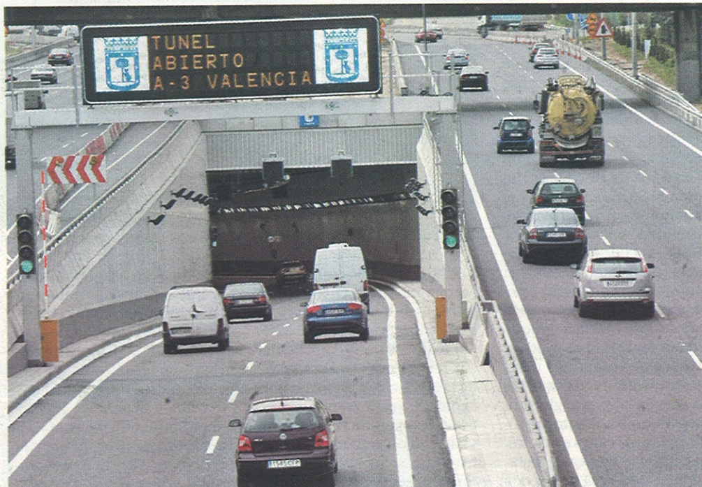
Túnel A3. Ahorra a los conductores unas 260.000 horas de viaje al año.
