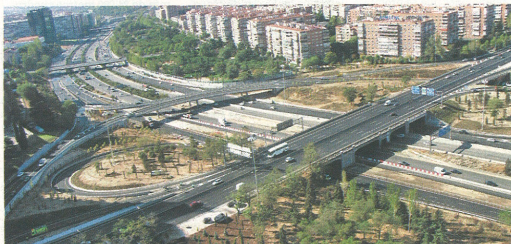
A2 fluida. Los cambios en esta conexión han mejorado el tráfico con el Corredor del Henares.
